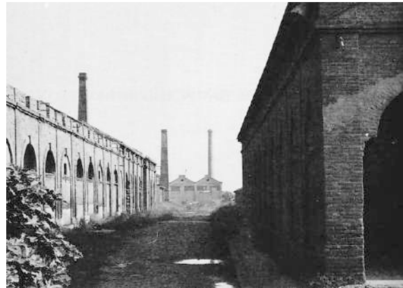
Fàbrica de "Gas Lebon"
